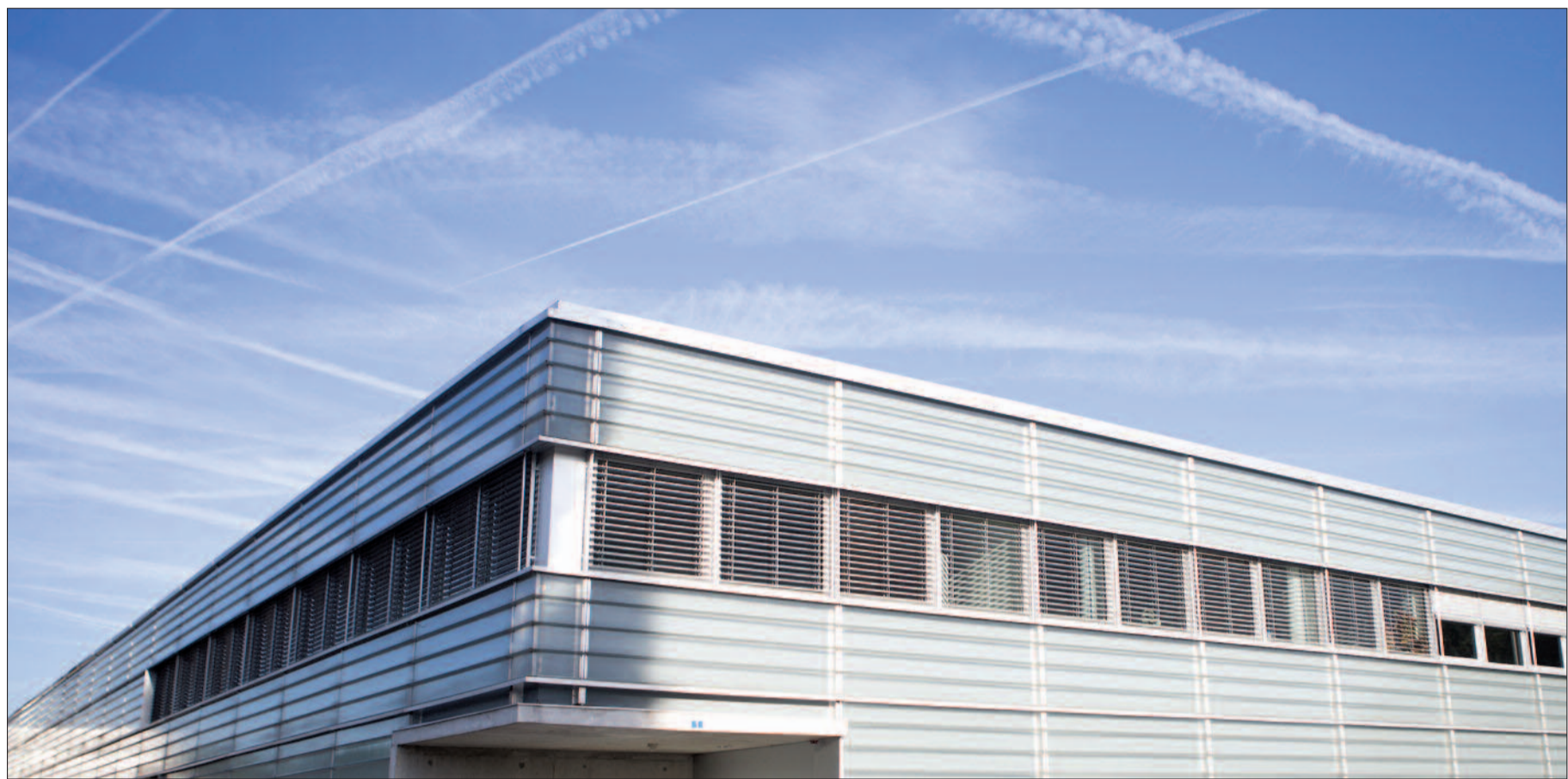
Le toit de l'entreprise SINEF SA va permettre de produire quelque 160 000 kWh d'électricité photovoltaïque. CHLOÉ LAMBERT
